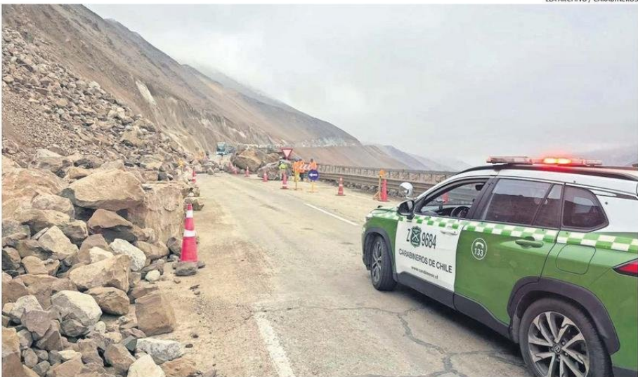
LOS DERRUMBES HAN CAUSADO QUE EL TRÁNSITO POR LA VÍA NO SEA FLUÍDO, LO QUE AFECTA ECONÓMICAMENTE.
