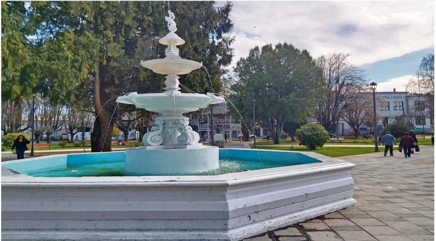
LA PILETA CENTRAL DE LA PLAZA DE LA CONCORDIA DE LA UNIÓN FUE LEVANTADA EN 70 CENTÍMETROS, PARA OPTIMIZAR EL SISTEMA DE CAPTACIÓN DE AGUAS LLUVIA HACIA EL PERÍMETRO DEL ÁREA VERDE.
