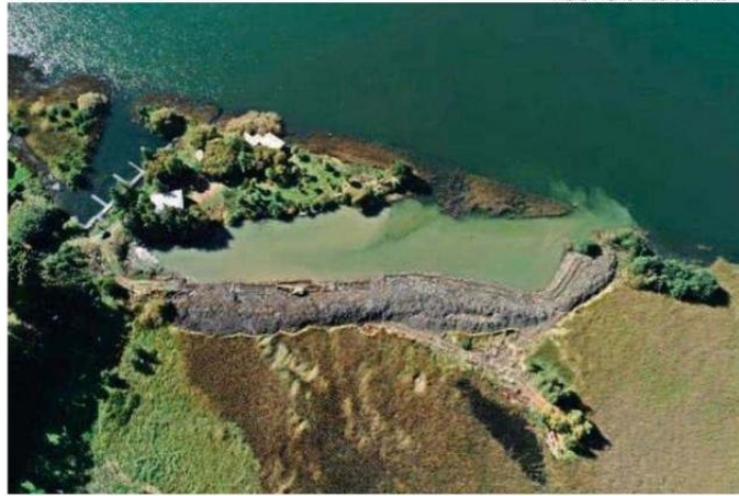
EL DAÑO A LA ZONA FUE CERTIFICADO MEDIANTE UN INFORME REALIZADO POR EL CEHUM.
