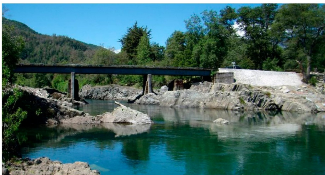
EL ACTUAL PUENTE LAS BASAS, de madera y 39,9 metros de longitud, conecta los valles Huequecura y Quillaileo, en la comuna de Santa Bárbara.
