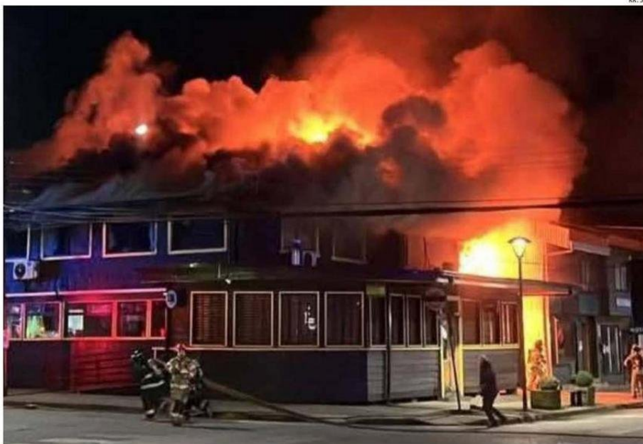
LAS LLAMAS SE APODERARON EN POCOS MINUTOS DE LA ESTRUCTURA QUE TAMBIÉN ALBERGÓ AL DIARIO LA ESTRELLA DE CHILOÉ.
