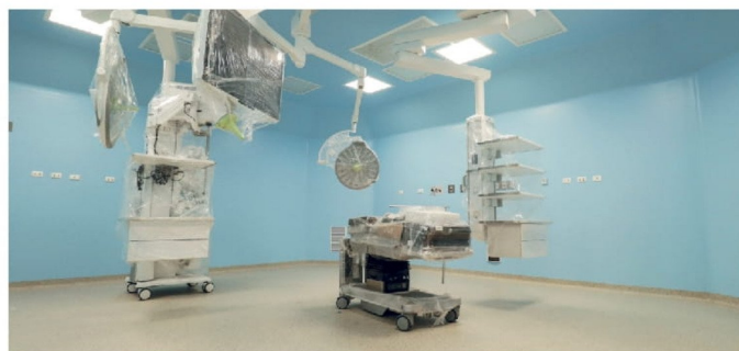
El recinto cuenta con nueve pabellones quirúrgicos con pisos de poliuretano cemento, material que permite mantener de mejor forma la higiene.
