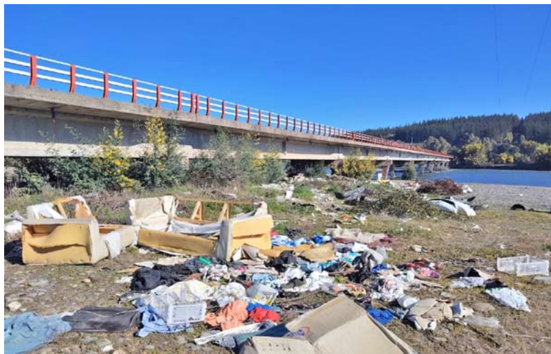
Bajo el puente El Ala la acumulación de desperdicios es evidente.
