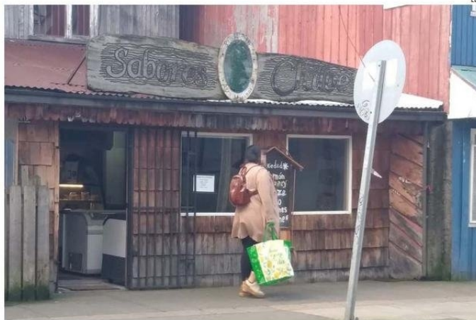
EL LOCAL AFECTADO SE ENCUENTRA EN CALLE SERRANO, CASI FRENTE AL MALL PASEO CHILOÉ.
