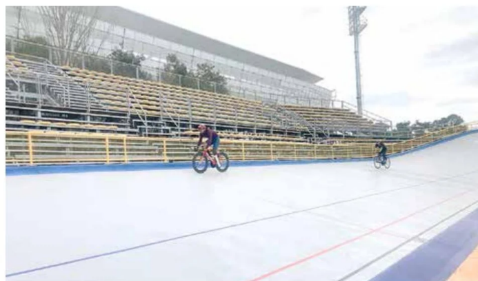
La marcha blanca de este nuevo espacio para la práctica del deporte, espera las observaciones y posibles mejoras, antes de su recepción final fechada para marzo de 2026.
