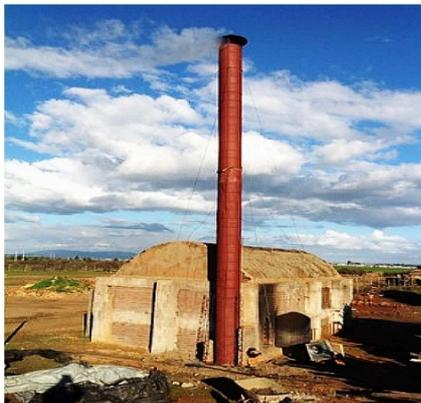
áneamente ladrillos en un Ecohorno y en un horno tradicional tipo chonchón. Las mediciones, efectuadas por una empresa externa, confirmaron la disminución del 75% en material particulado y una baja general en gases contaminantes.
