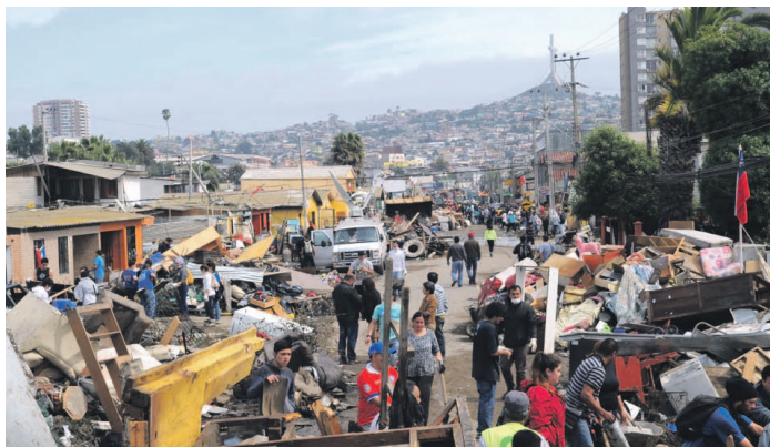
Imágenes de aquel mes de septiembre de 2015, cuando el barrio Baquedano de Coquimbo vio su existencia golpeada producto del tsunami generado por un sismo de 8,4 grados.
