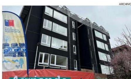
El icónico edificio de los años 70 fue completamente remodelado.
