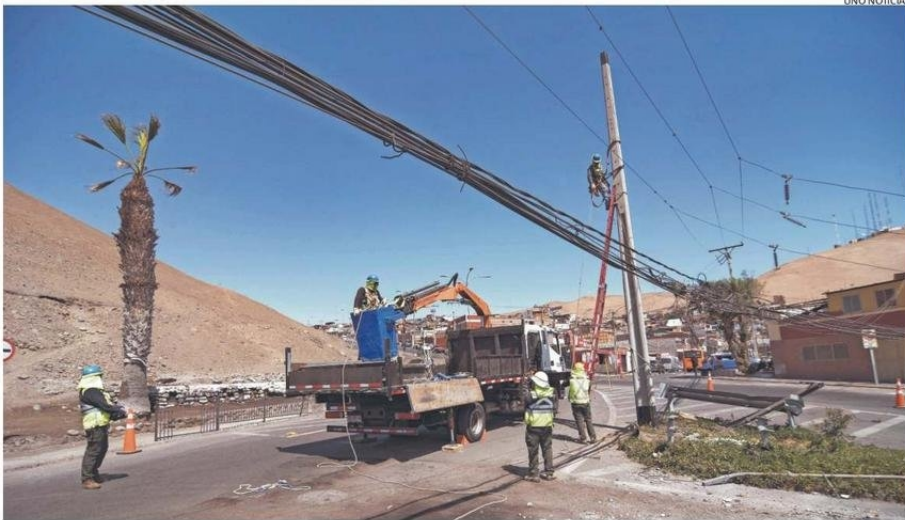
LOS TRABAJOS DE REPOSICIÓN SE EXTENDIERON POR VARIAS HORAS DEBIDO A LA COMPLEJIDAD EN LA REPOSICIÓN DEL POSTE.
