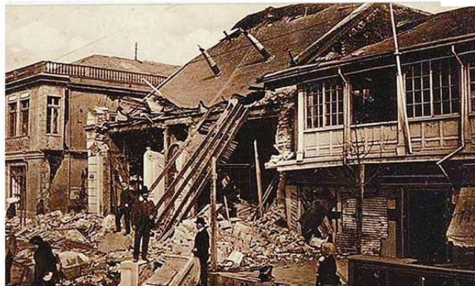
UN REGISTRO DE COMO QUEDÓ UNA CASA DE ALMIRANTE MONTT LUEGO DEL SISMO DE HACE 119 AÑOS.
