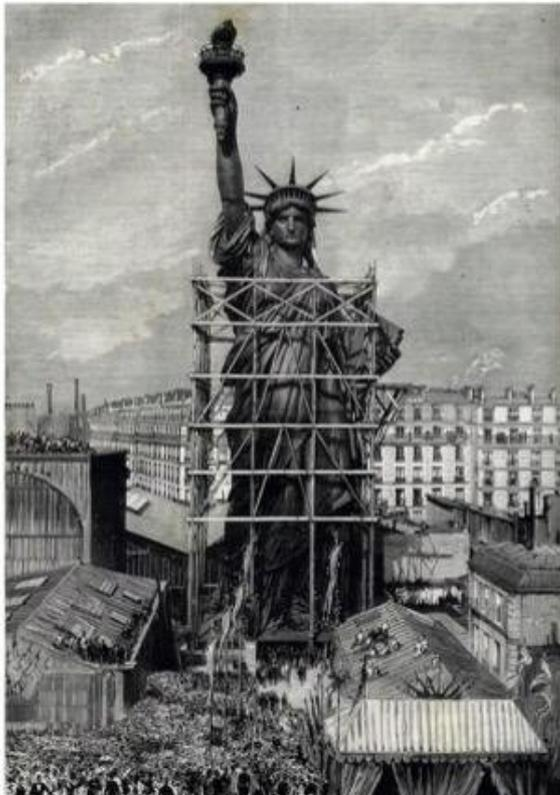
En 1881, Eiffel diseñó la estructura interna de la Estatua de la Libertad, garantizando su resistencia a los vientos y al paso del tiempo.
