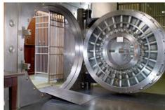
**Bóveda** | Esta cámara, una de las más representativas del Banco Central, es obra de la empresa norteamericana Diebold Safe & Lock Company. Tiene una puerta de acero inoxidable de 4,5 toneladas, paredes blindadas con tres capas de acero y sistemas de aperturas basados en un complejo mecanismo de horas y claves.
