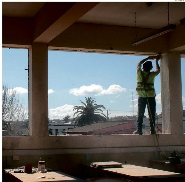
LAS ANTIGUAS VENTANAS DEL ESTABLECIMIENTO DATAN DE 1958.
