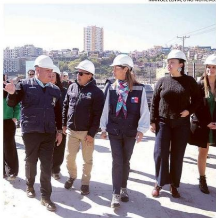
OBRAS, EN SU PRIMERA ETAPA, YA ALCANZAN UN 41%.
