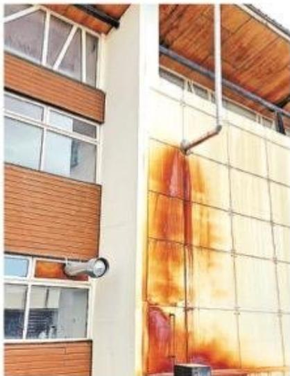
En el exterior del establecimiento persisten -y se siguen extendiendo- grandes manchas de óxido en los muros, provocadas por las lluvias y la nieve en los caños de salida de gases de la calefacción y en el interior, además, han vuelto las goteras en algunas salas de clases.
