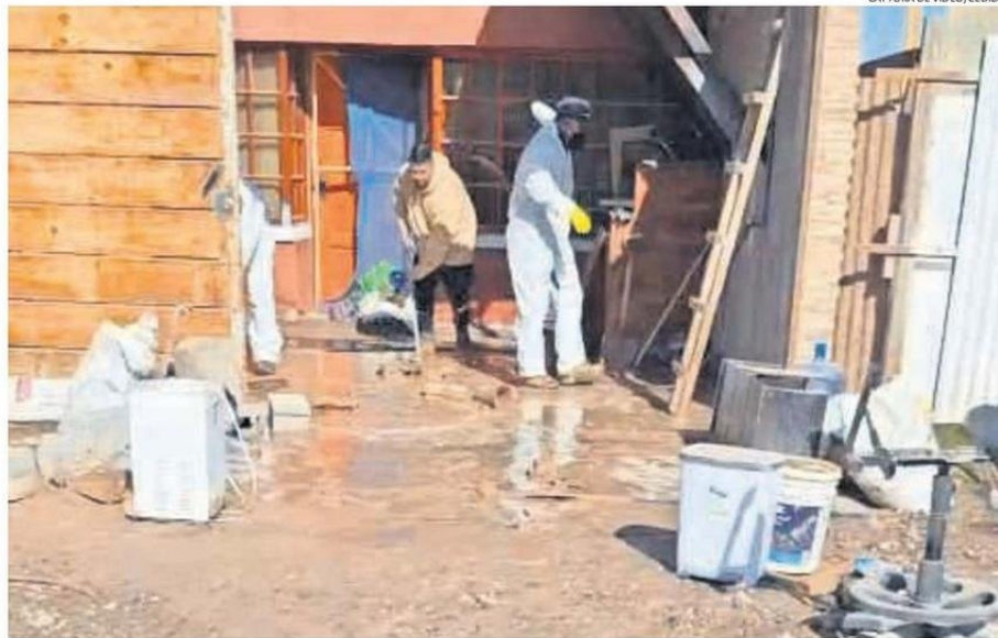
INUNDACIONES HAN PROVOCADO DAÑOS MATERIALES A LOS VECINOS QUE RESIDEN EN EL SECTOR.
