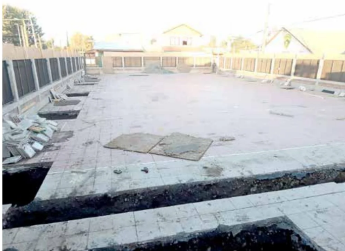
Trabajos de mejoramiento en plena ejecución.
