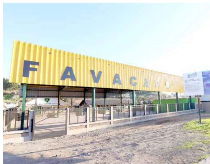
Terminó construcción de mejoramiento de recinto deportivo de la Población Curicó.
