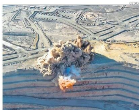
UN DISPARO MULTICOLOR MARCA EL INICIO DE LA FASE DE PRESTRIPPING.
