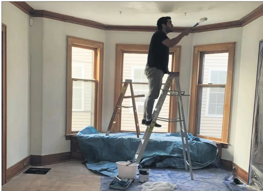
Daniel Ávila y su esposa renovaron muros y cielos de toda la casa.
