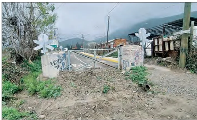
Las obras comprometidas están a punto de terminar, por lo que estarían las condiciones para abrir el portón en las próximas semanas.
