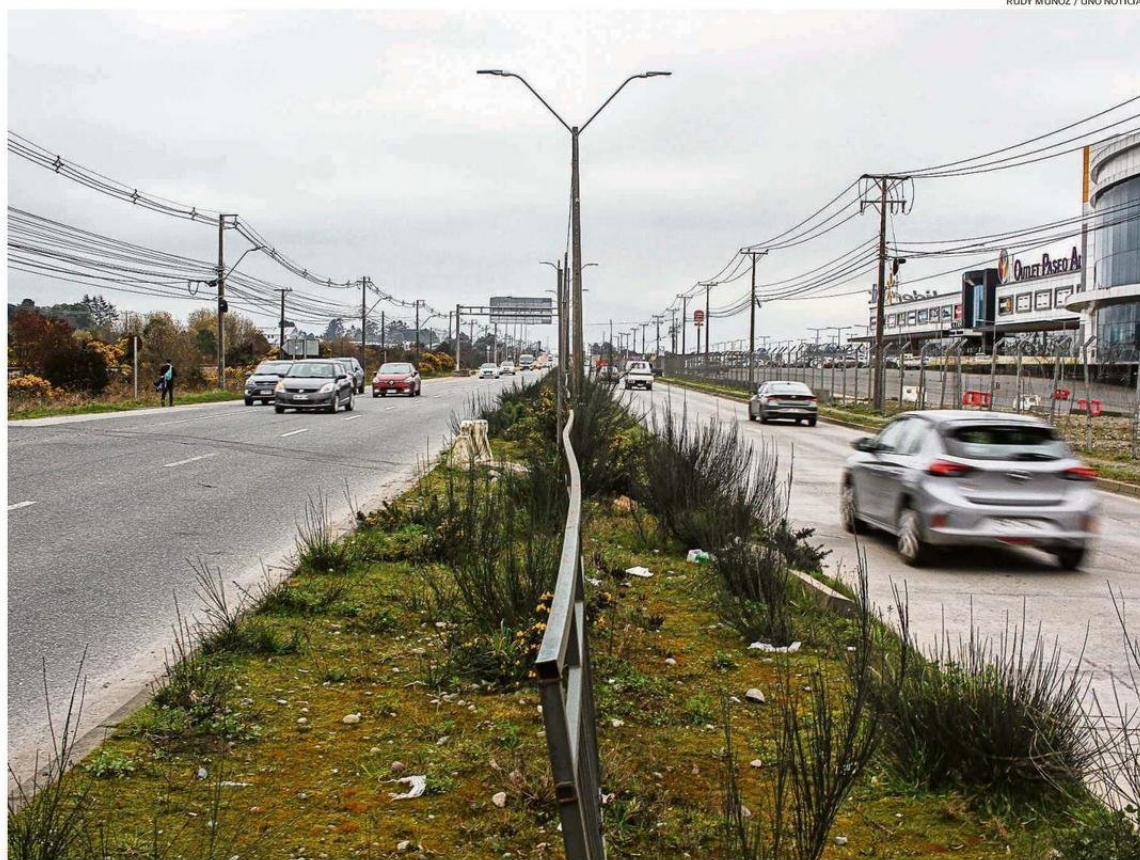
LA VÍA ELEVADA, CON LO QUE SE TERMINARÍA EL PROYECTO DE INTERCONEXIÓN VIAL, PASARÁ SOBRE LA AVENIDA FERROCARRIL Y OCUPARÁ PARTE DEL TERRENO DEL OUTLET ALERCE.
