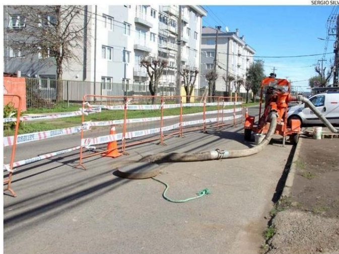
CON UNA MOTOBOMBA EXTRAEN MATERIAL QUE ES ARROJADO A OTRAS CÁMARAS DEL SECTOR.
