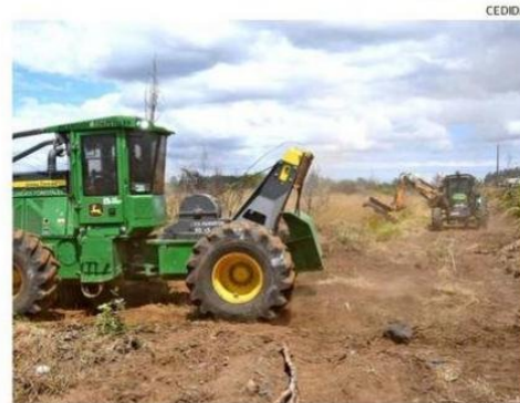
SE HA ALCANZADO LA CIFRA DE 121 KILÓMETROS DE CORTAFUEGOS EJECUTADOS EN SECTORES CRÍTICOS.
