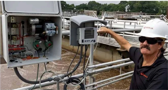
Lecturas de los sensores en un controlador IQ SensorNet 2020 3G.
