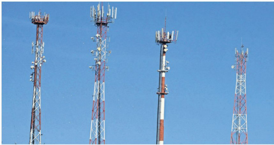
LAS ANTENAS RADIALES EN TARAPACÁ NECESITAN ELECTRICIDAD PARA PODER TRANSMITIR.
