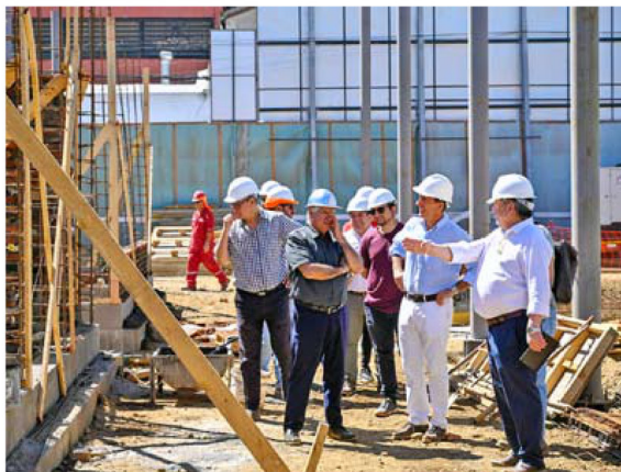
Las obras de mejoramiento del Patio Isabel Riquelme presentan un 25% de avance.
