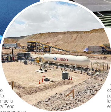
Planta GASCO de calentamiento de pilas de lixiviación.
