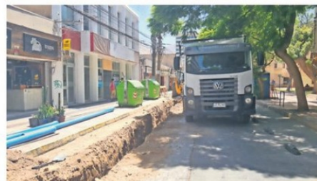
60% DE AVANCE LLEVA LA OBRA EN CHACABUCO SEGÚN EMPRESA SANITARIA.
