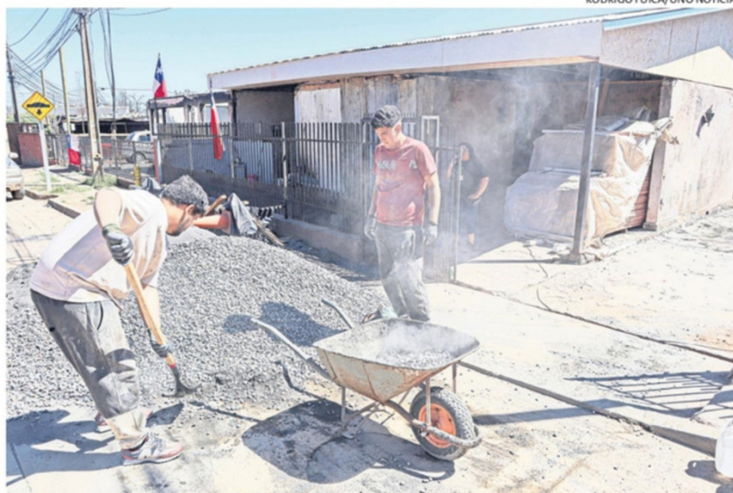
EN EL SECTOR VIPLA, VECINOS RECONSTRUYEN SUS VIVIENDAS CON SUS PROPIOS MEDIOS.
