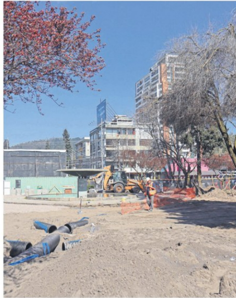
Desde el invierno del 2025 la Plaza Perú y sus alrededores se cerraron para realizar las obras de remodelación.
