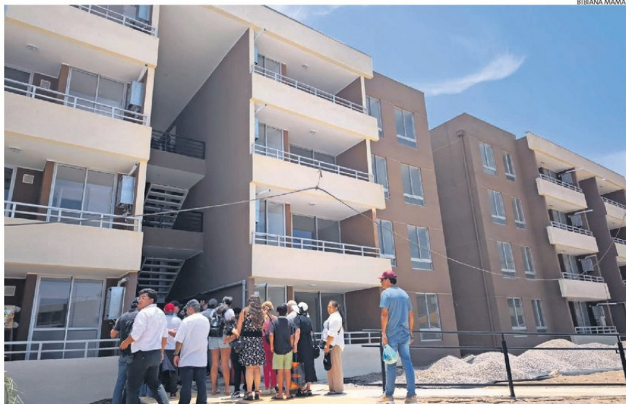
FAMILIAS ESTÁN A LA ESPERA DE QUE SE TERMINEN LOS TRABAJOS Y REPARACIONES DE SUS VIVIENDAS PARA PODER HABITARLAS.
