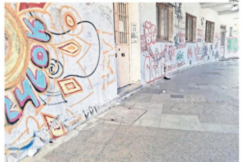
FACHADAS COMPLETAMENTE RAYADAS Y CON OLOR A ORINA.
