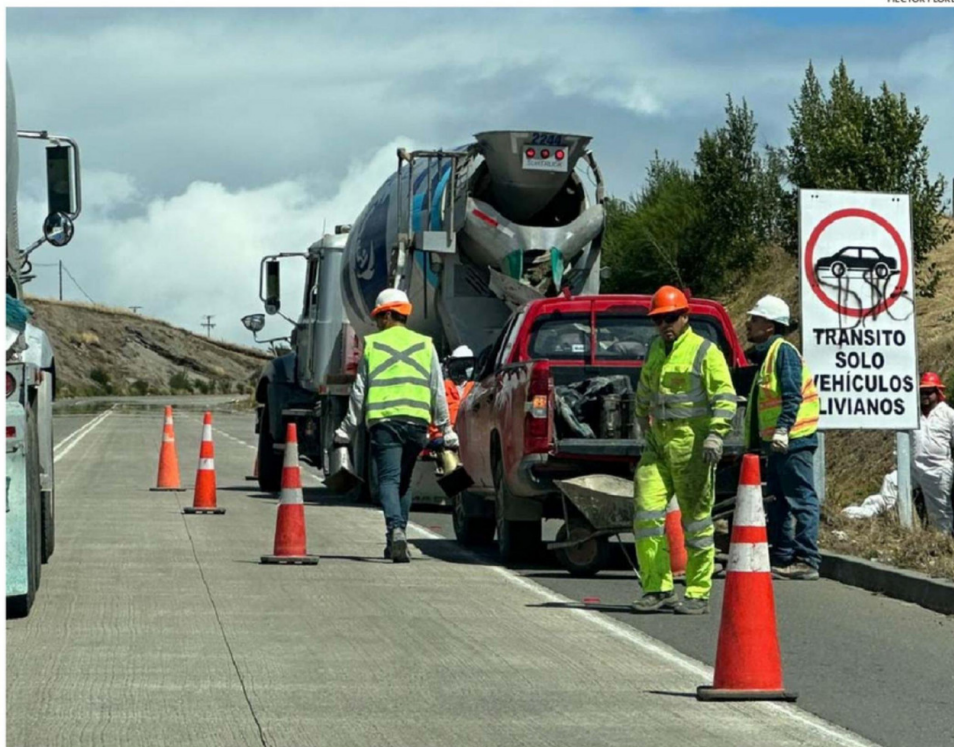
LA EMPRESA SICOMAQ ESTÁ TRABAJANDO EN EL TRAZADO PARA CUMPLIR EL COMPROMISO DE ABRIR EL TRÁNSITO EN MARZO.
