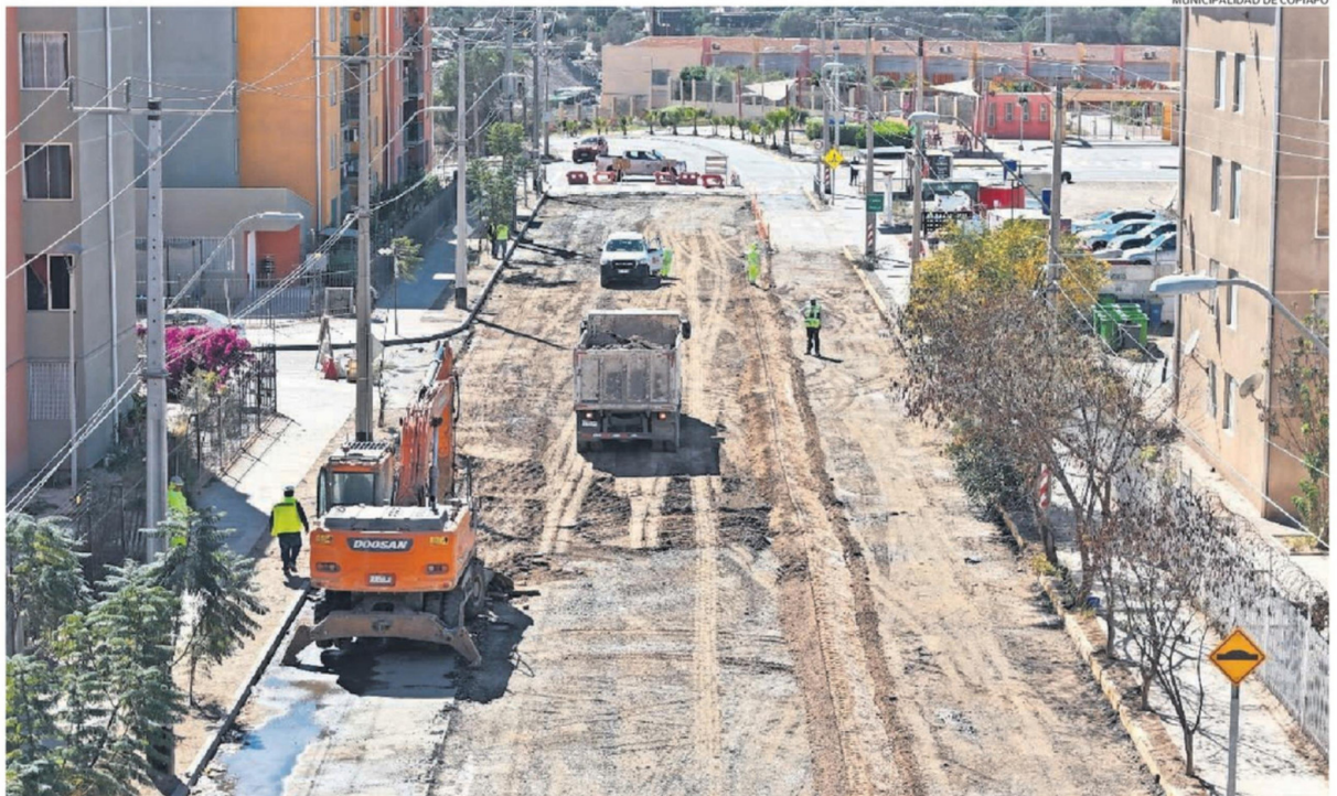
TRABAJOS DE PAVIMENTACIÓN EN AVENIDA LUIS FLORES DURANTE EL 2024 Y QUE ERA PARTE DEL PROYECTO "CONSERVACIÓN DE CALLES Y VÍAS COPIAPÓ III ETAPA".
