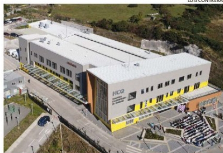
VISTA AÉREA DEL NUEVO ESTABLECIMIENTO ASISTENCIAL QUEILINO.
