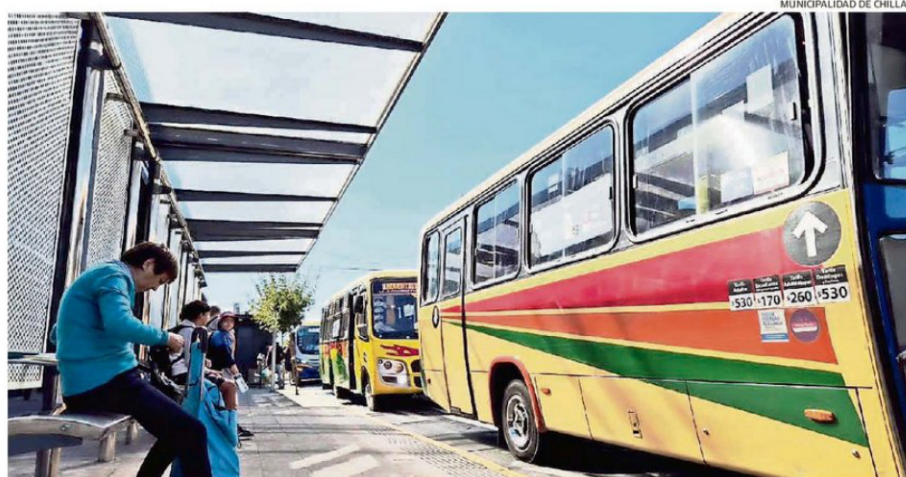
LAS NUEVAS ESTRUCTURAS INCLUYEN PANELES DE INFORMACIÓN VARIABLE PARA ORIENTAR A LOS USUARIOS.
