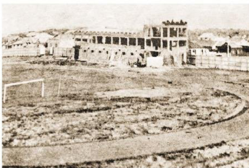
Panorámica del estadio de la Confederación Deportiva en periodo de plena construcción en 1935.
