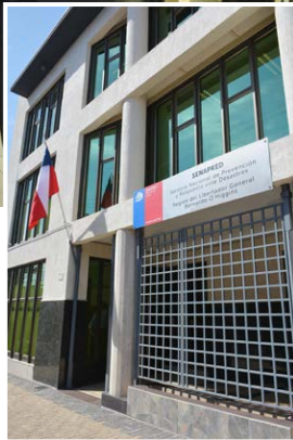
Nuevo edificio de Senapred, ubicado en calle Cuevas #150.
