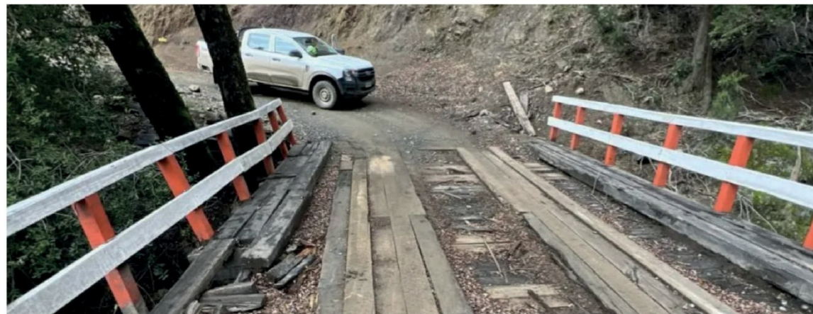
LA OBRA, CONSIDERADA CLAVE para la comunidad de Cauñicú, comenzará tras ajustes operativos derivados de las condiciones del camino.
