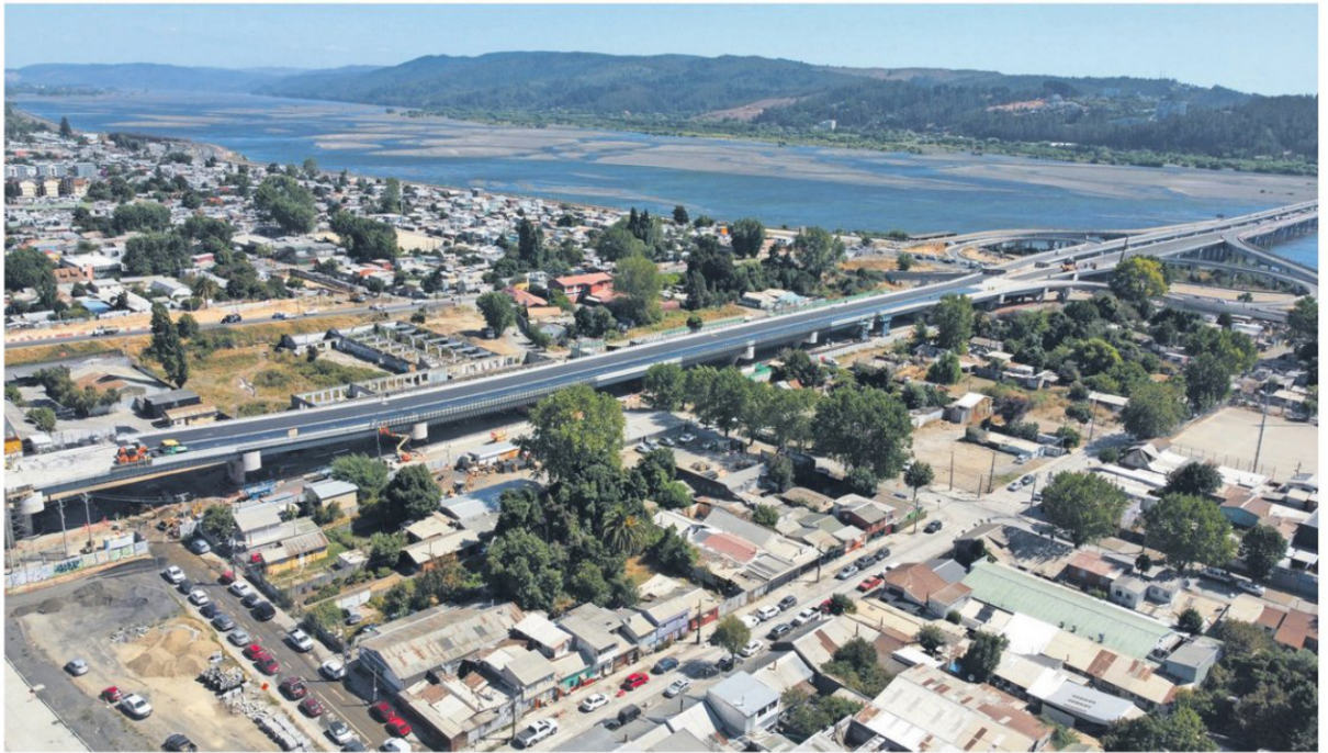
Obras estructurales en Concepción, Talcahuano y San Pedro de la Paz han generado un mayor estrés vial en el Gran Concepción.
