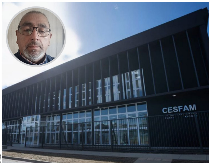
El edificio se convertirá en el Cefam más importante de la capital regional.
