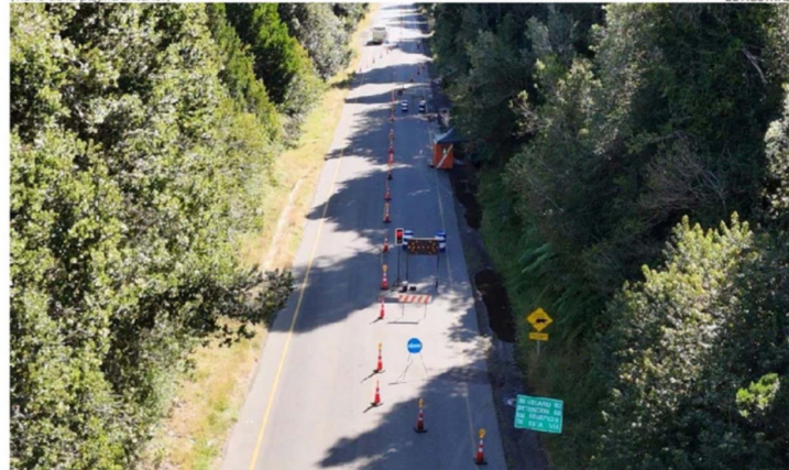
LA RUTA 215, ENTRE LA ADUANA Y EL LÍMITE, ESTÁ SIENDO INTERVENIDA PARA MEJORAR LA CARPETA DE ASFALTO.
