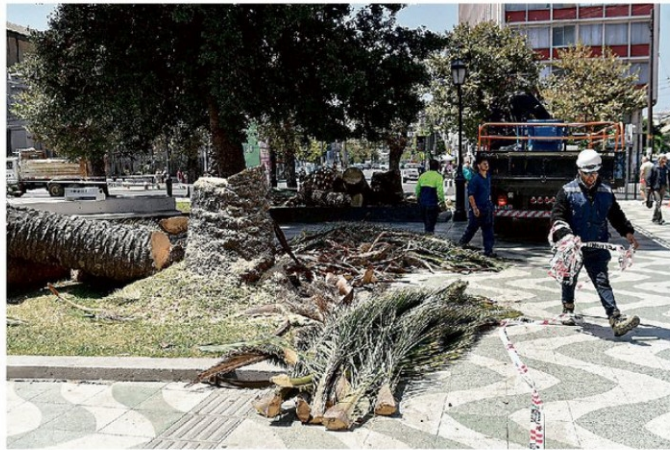
TRABAJOS DE TALA REALIZADOS AYER EN LA PLAZA VICTORIA PARA MITIGAR RIESGOS.
