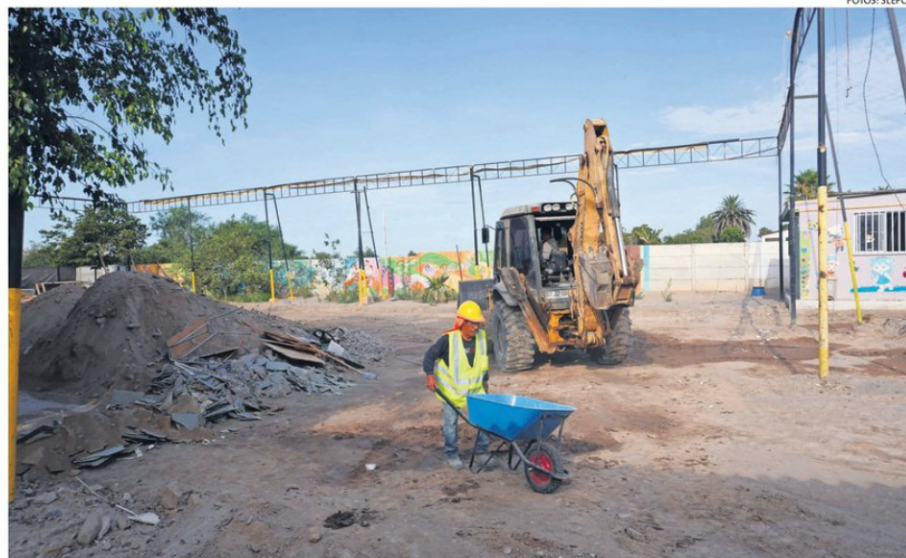
LA MAYORÍA DE LOS RECINTOS ESTÁN TERMINANDO DE REFACCIONARSE O SER MEJORADOS.
