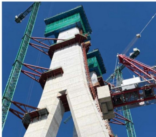
LAS TRES PILAS DEBERÍAN ESTAR TERMINADAS ESTE AÑO.
