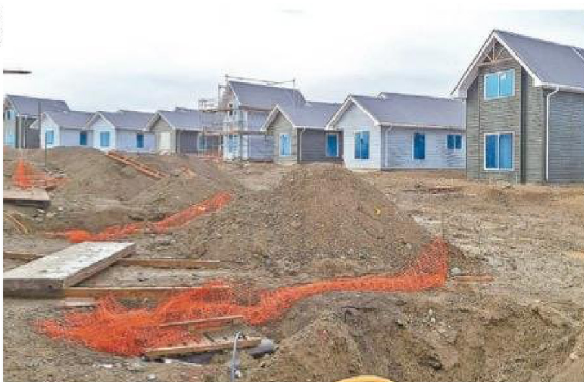
Las 49 soluciones habitacionales del subsidio rural, traducidas en viviendas sociales, conforman el loteo ya construido, cuya entrega se espera para inicios del próximo mes, en un terreno que bordea el río Side, en la parte baja de Cerro Sombrero.
